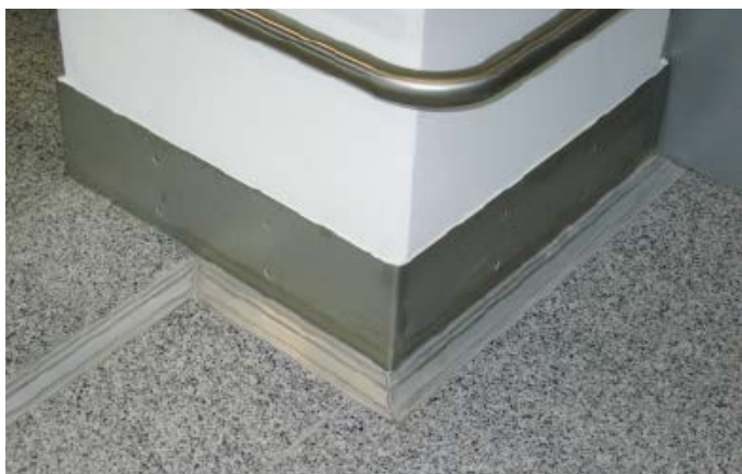
Aéroport de Francfort, Allemagne
