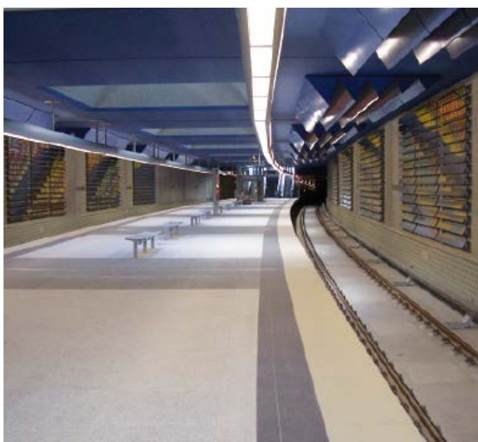
Aéroport Hambourg, Allemagne, sous-sol
