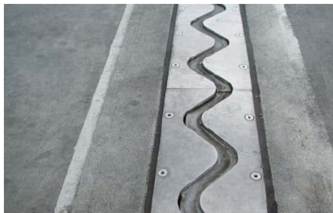
Aéroport de Francfort, Allemagne
